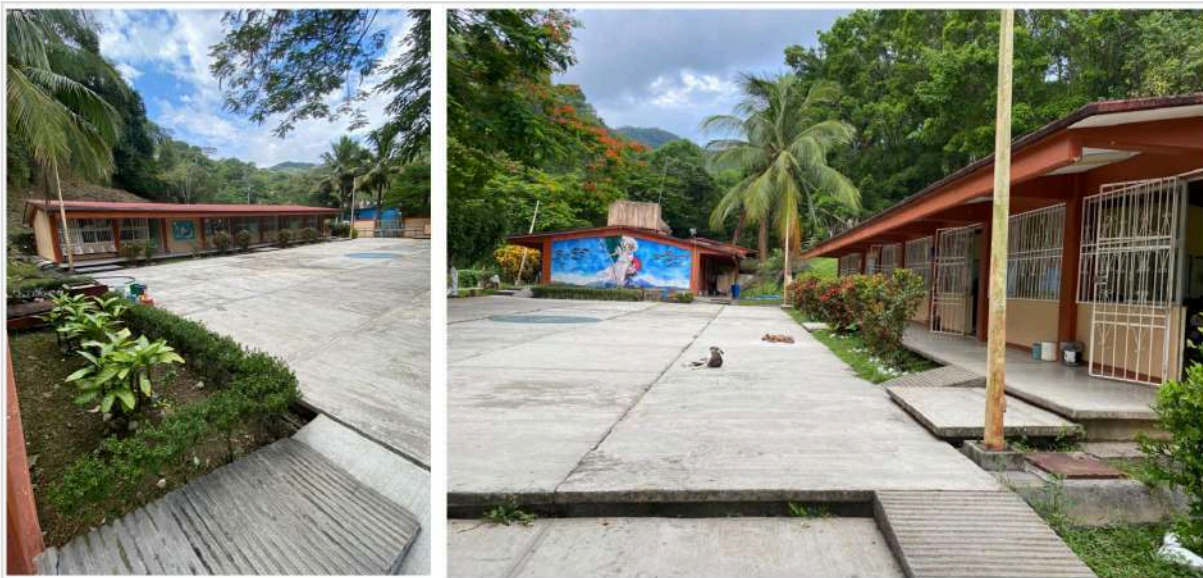
Figura 3.5 Edificio 1 de la Telesecundaria 115.
