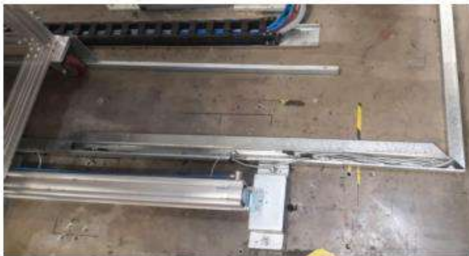
Figura 41.- Montaje de los rieles y pistón del carro de traslación.
