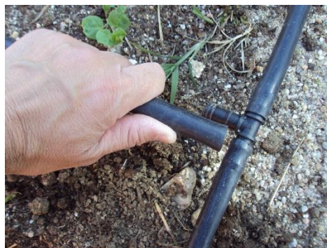
Figura 5.19 “Tes” utilizadas para unir las líneas de riego.
