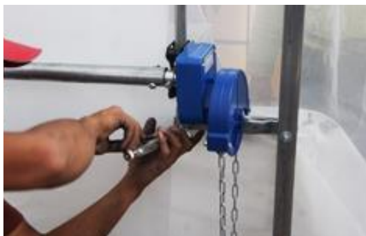
Figura 5.15 Instalación del sistema de ventilación
