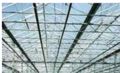
Figura 3.7. Fotografía del interior del invernadero tipo Capilla.
