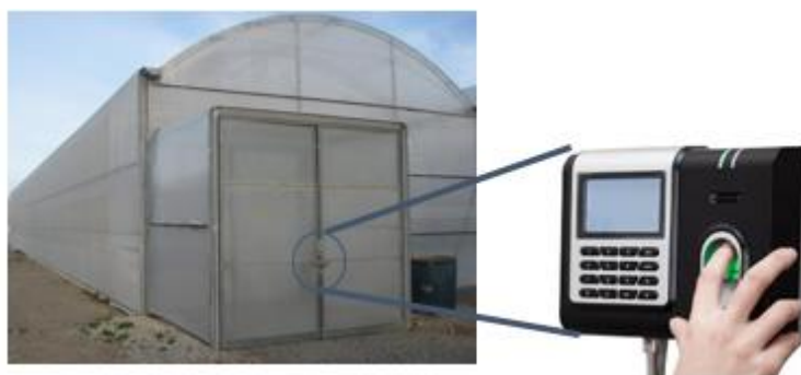
Figura 5.13 Entrada del invernadero automatizada
