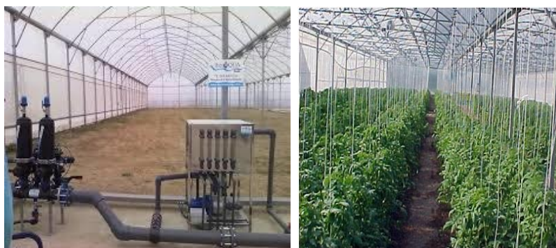
Figura 5.21 Sistema automático de riego por goteo
