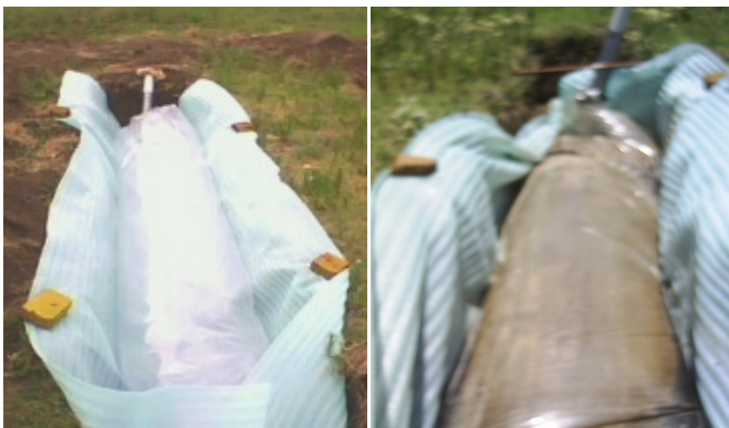
Figura 8 Instalación del digestor anaerobio de 500 l.
