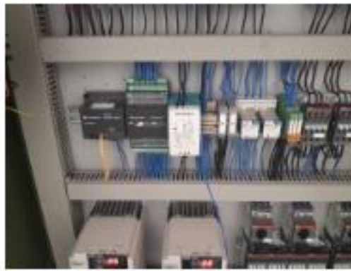
Figura 2.56: Tablero sección de fuente y módulos de expansión.
