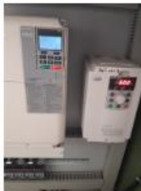
Figura 2.58: Tablero seccion de VDF.
