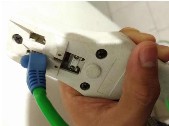
Figura 14. Ponchado de cable UTP
