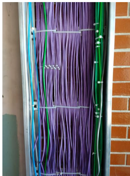
Figura 18. Fijar Cables UTP
