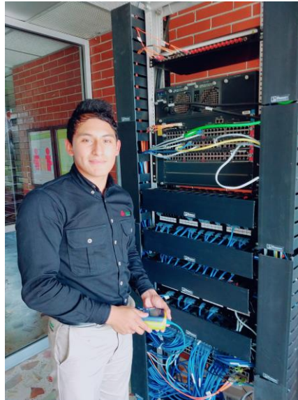
Figura 35. Cable estructurado finalizado
