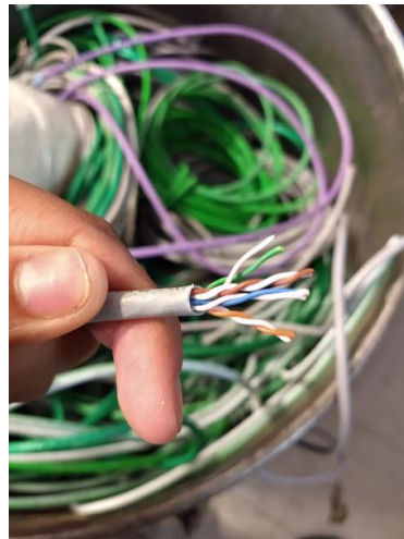
Figura 12. Pelar el cable UTP
