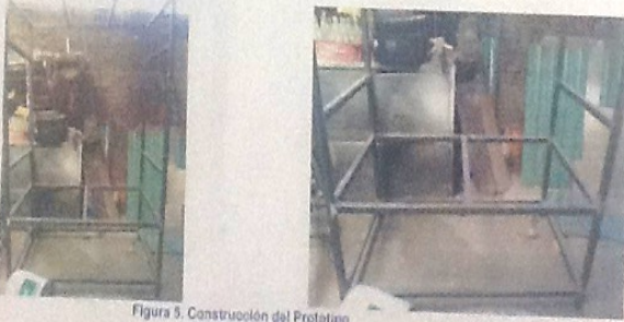
Figura 5. Construcción del Prototipo
